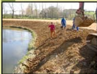
Protection des berges de l'Oust (75m) par un fascinage de saules
