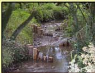
Diversification des habitats piscicoles par la pose d'épis et de risbermes
